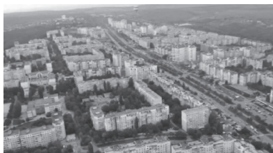
Fig. 3. Chișinău. Fotografie aeriană (din avion) https://i.ytimg.com/vi/10ziZLKwgCY/maxresdefault.jpg
